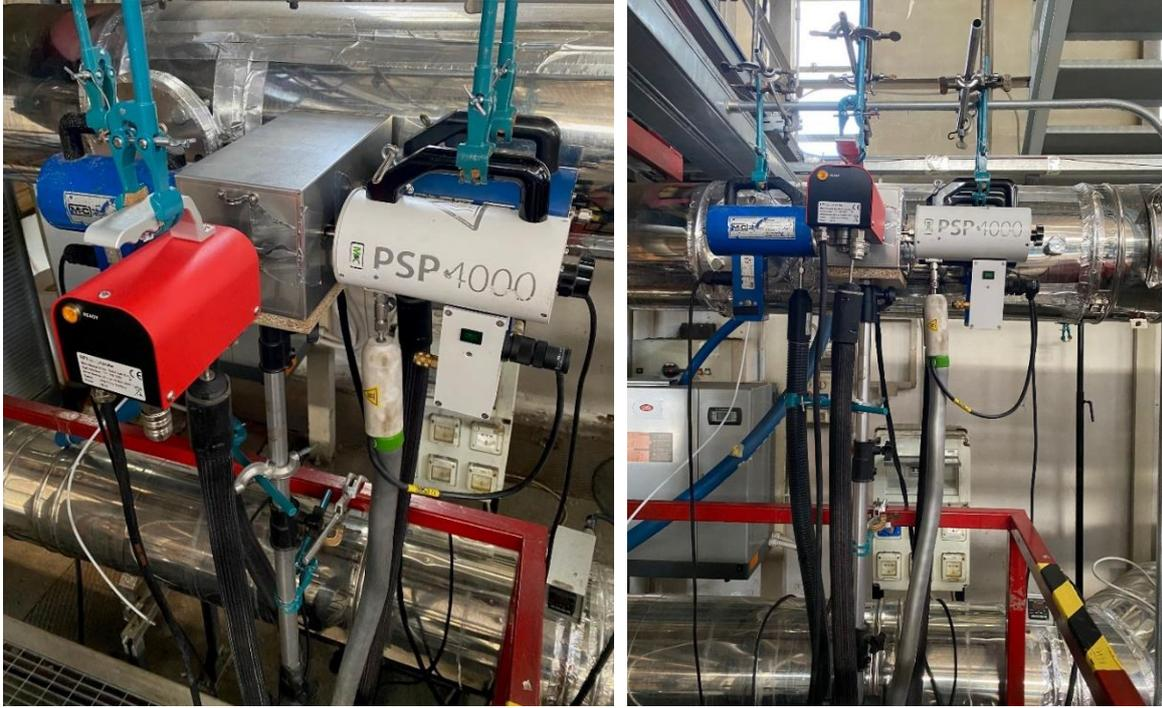
*Figura 1 punti di prelievo e sonde riscaldate*
